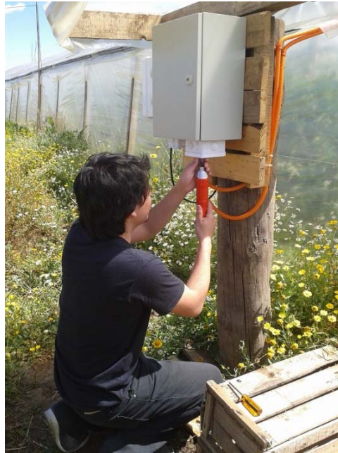
Figura 49: Instalación del prototipo 3.
