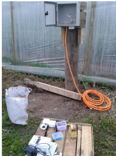
Figura 31: Instalación del prototipo 2.
