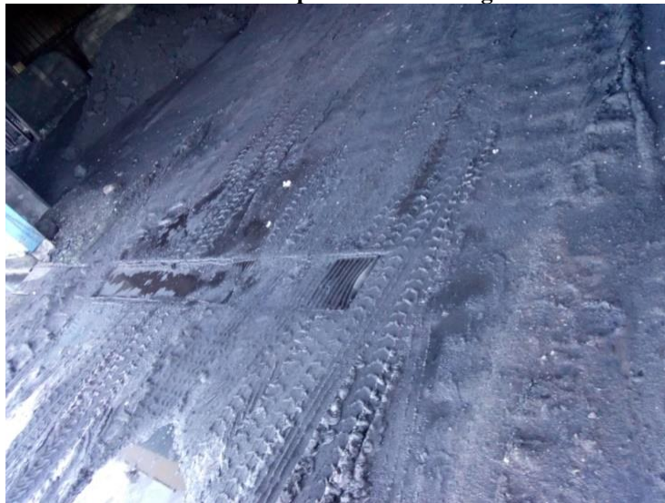
Ilustración 16: Canaleta por donde hace ingreso el camión
