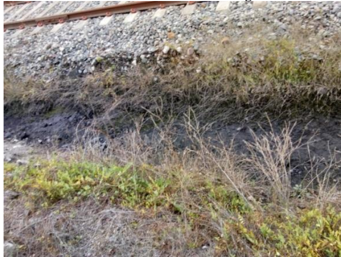
Ilustración 13: Canal aledaño a la Bodega de Petcoke 1
