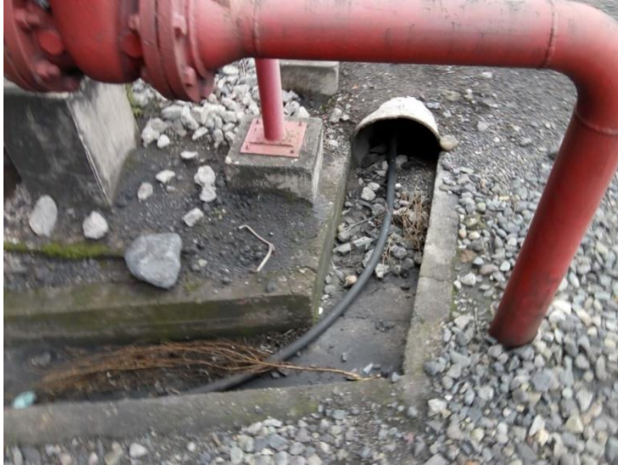
Ilustración 19: Final de la canaleta
