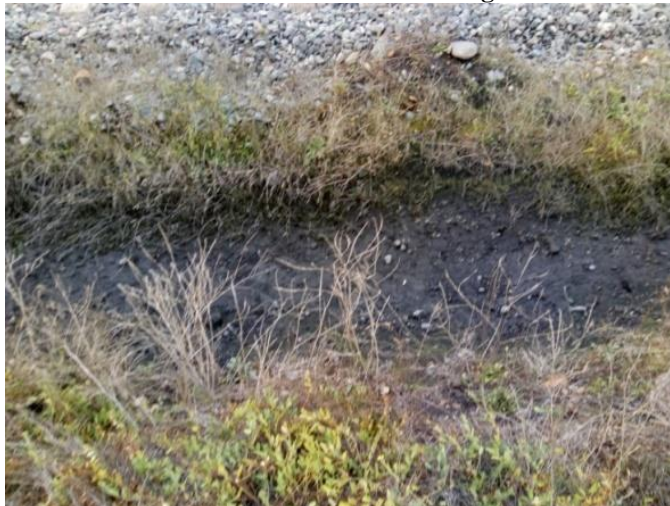
Ilustración 14: Canal aledaño a la Bodega de Petcoke 2
