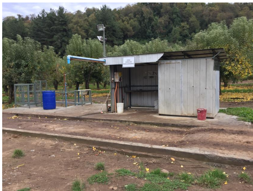
Ilustración 25: cargadero Los Gualles
