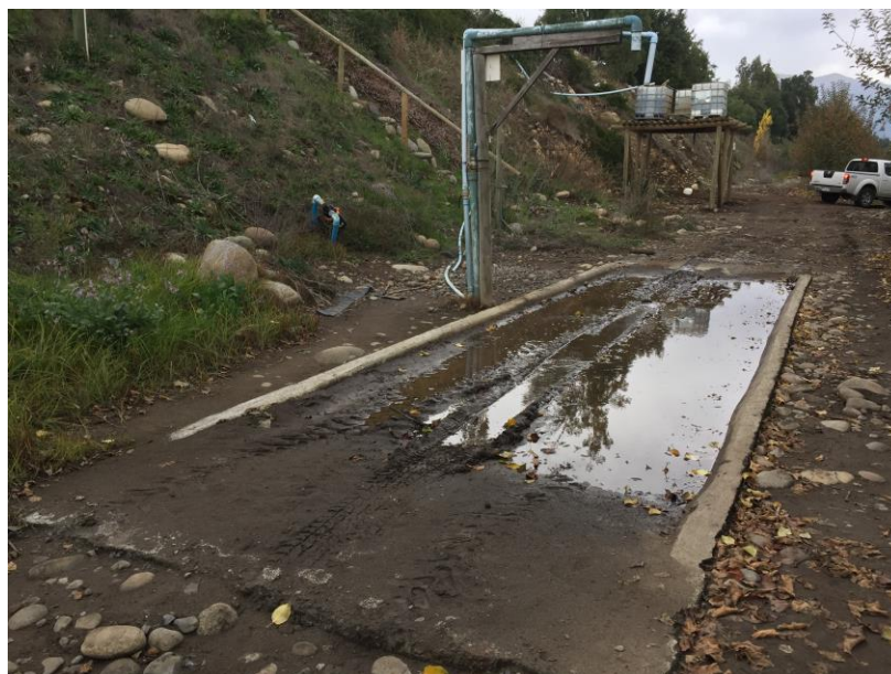
Ilustración 23: cargadero 2 San Luis
