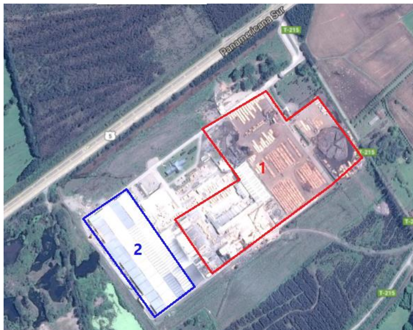
Ilustración 2: Vista aérea del Complejo de Maderas Valdivia
