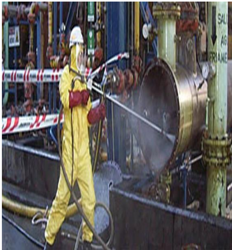
Ilustración 18: Lavado a alta presión 6000psi
