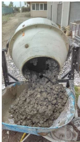
Ilustración 17: Descarga de mezcla en carretilla. Fuente: Elaboración propia.
