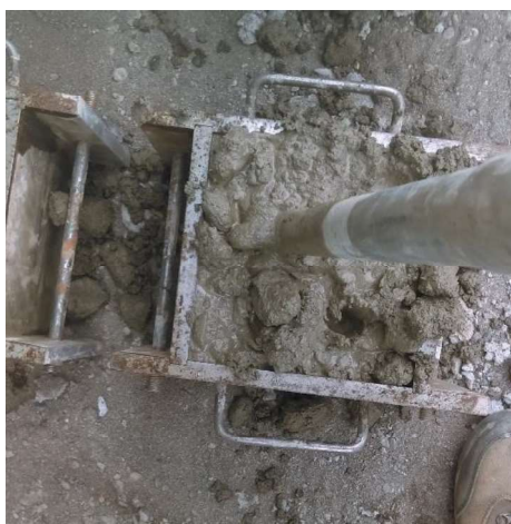
Ilustración 21: Vibrado de hormigón.
