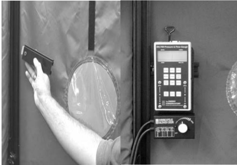
Ilustración 29: Instalación módulo para controlador
