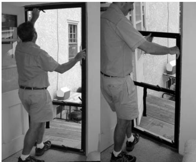
Ilustración 22: Instalación marco de aluminio
