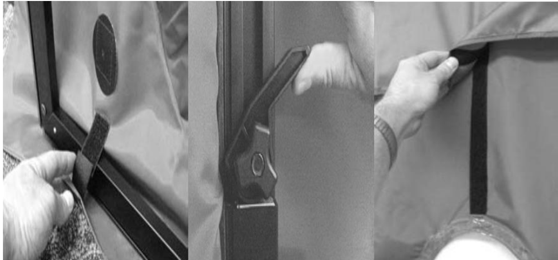
Ilustración 23: Instalación lona textil plástico
