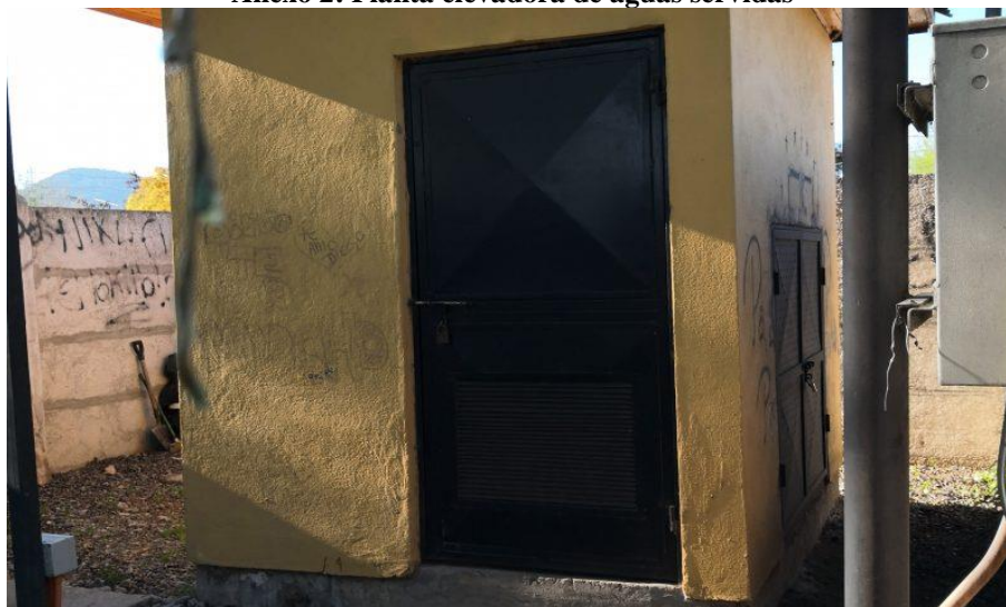
Anexo 2: Planta elevadora de aguas servidas
