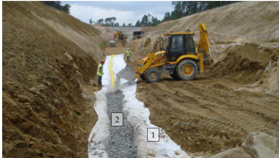
Figura 2-5. Dren con geotextil. 1) geotextil. 2) material basal, (construblogspain, 2014).
