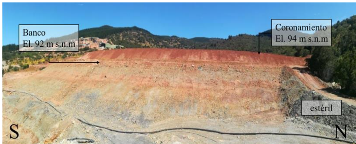
Figura 4-3. Fotografía actual del depósito de relaves de Chépica, autoría propia.
