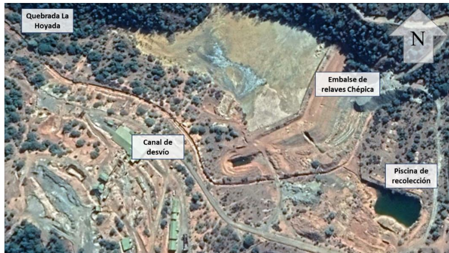
Figura 1-2. Embalse de relaves, vista aérea. Google Earth.
