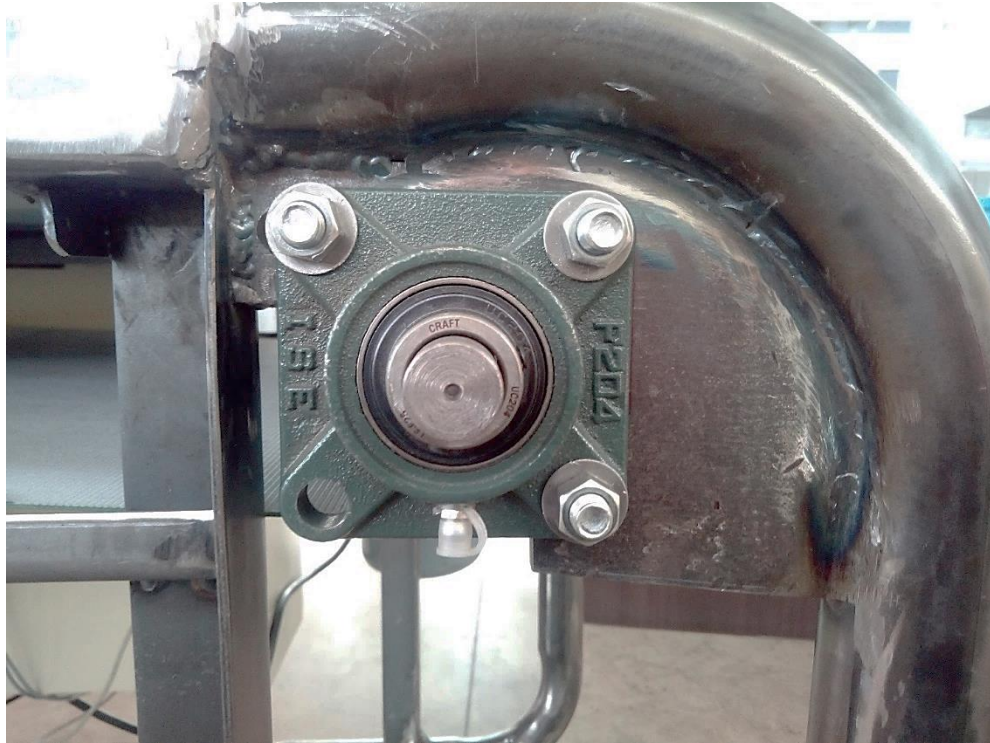
Figura 7.15: Soporte de brida UCF 204 instalado.
