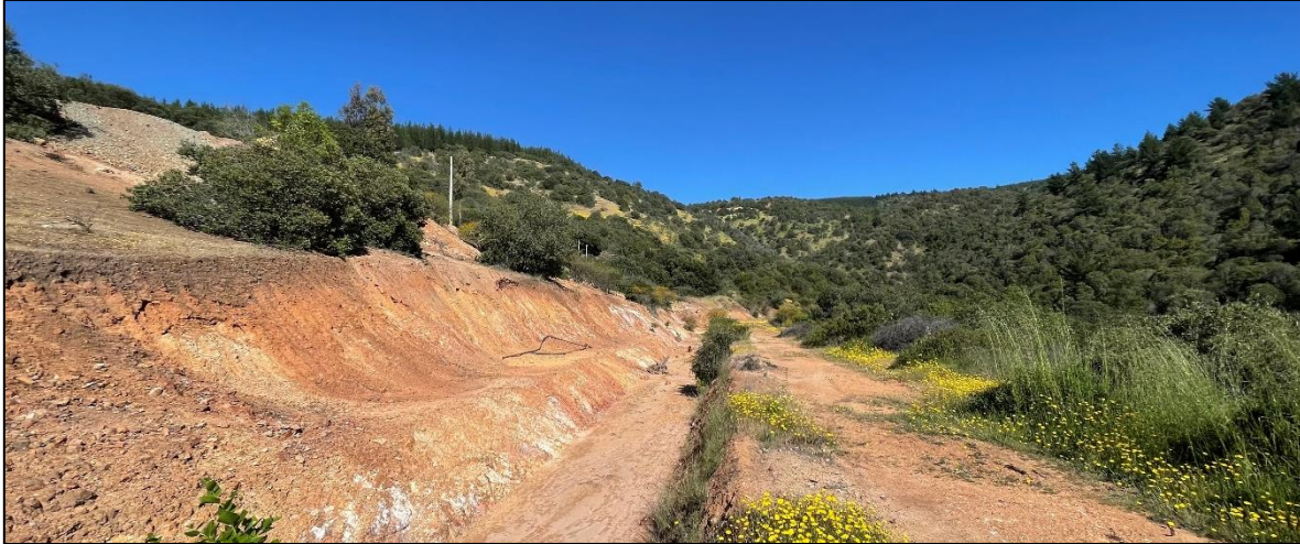
Figura 4.5: Canal de desvío de la quebrada la Hoyada (Elaboración propia).
