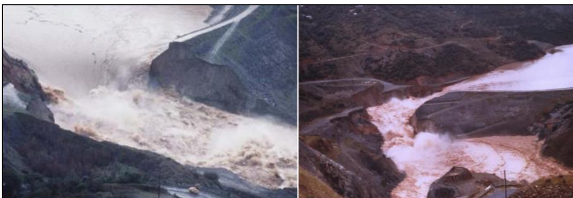
Figura 2.4: Falla por rebalse, presa Auburn, Cofferdam (Giovanetti, 2015)
