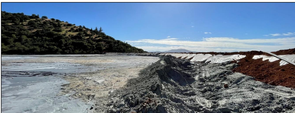
Figura 4.10: Imagen del relave depositado en la cubeta del depósito (Elaboración propia).
