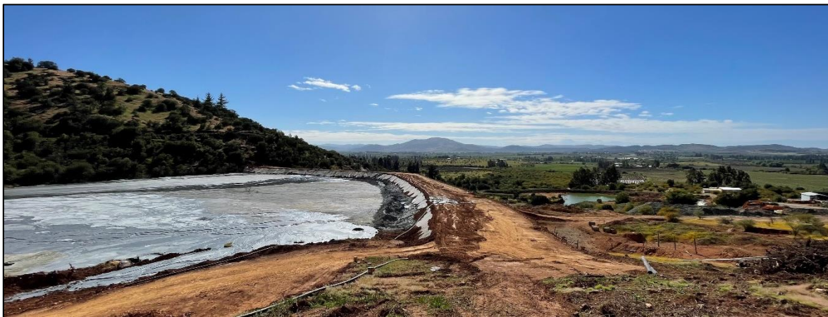
Figura 2.1: Embalse de relaves de Mina Chépica construido con material de empréstito de zonas aledañas 2021 (Elaboración propia).
