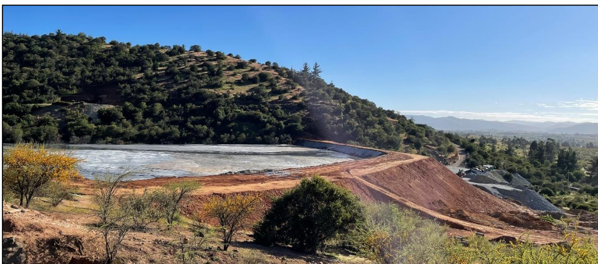
Figura 4.6: Muro del embalse de relaves de mina chéptica (Elaboración propia).
