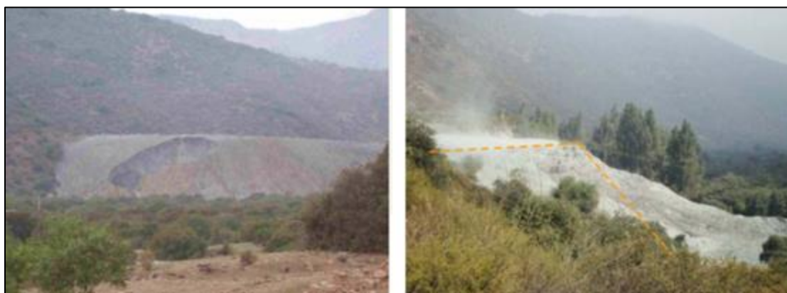
Figura 2.6: Falla por inestabilidad de talud (Palma, 2016)
