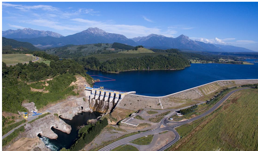
Figura 2-1: hidroeléctrica de embalse angostura [7].
