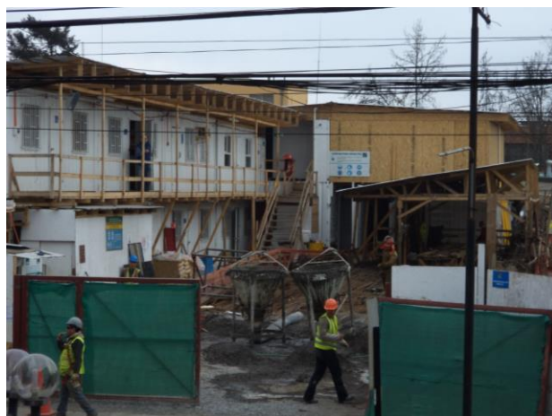
Figura N°27: Instalación de faenas dos niveles
