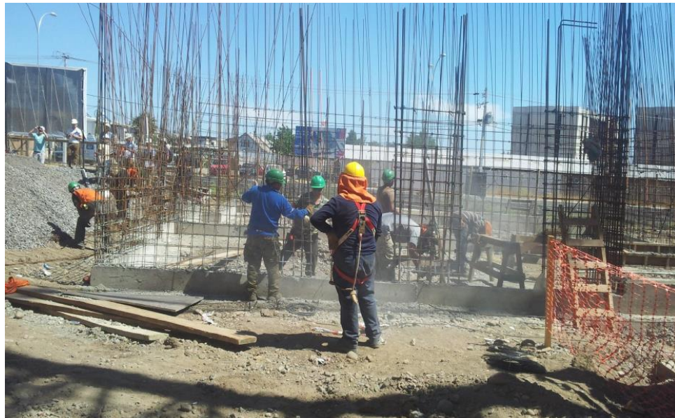
figura N°22: Registro fotográfico enfierradura de muros villa futuro
