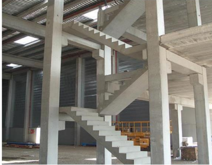
Figura N°38: Escaleras prefabricadas, elementos de hormigón industrializado en edificaciones CCHC
