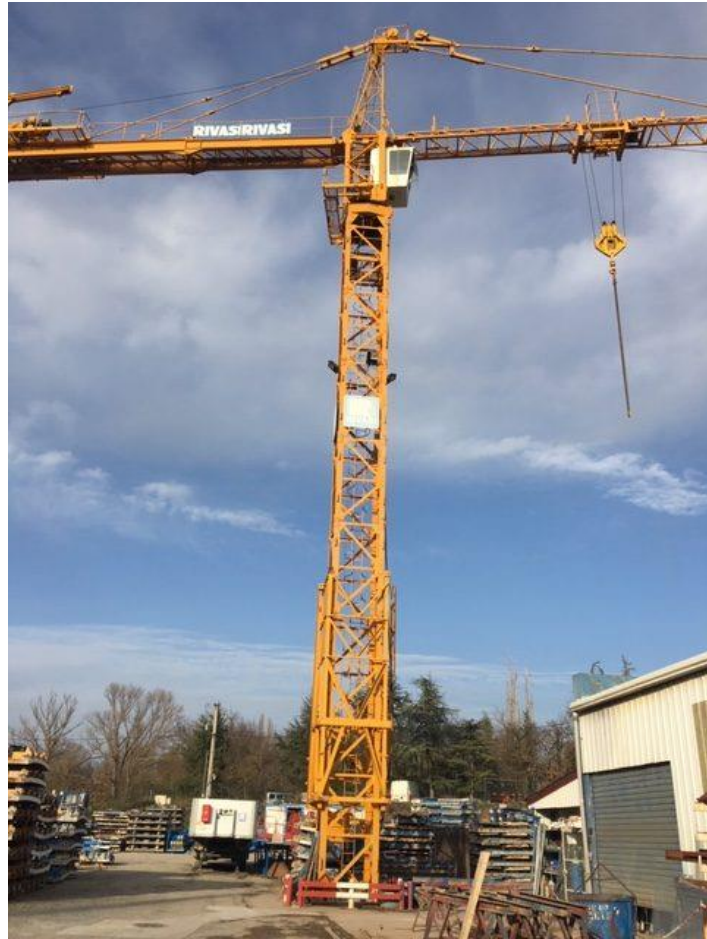
figura N°31: Grúa torre detallada en presupuesto de figura N°30
