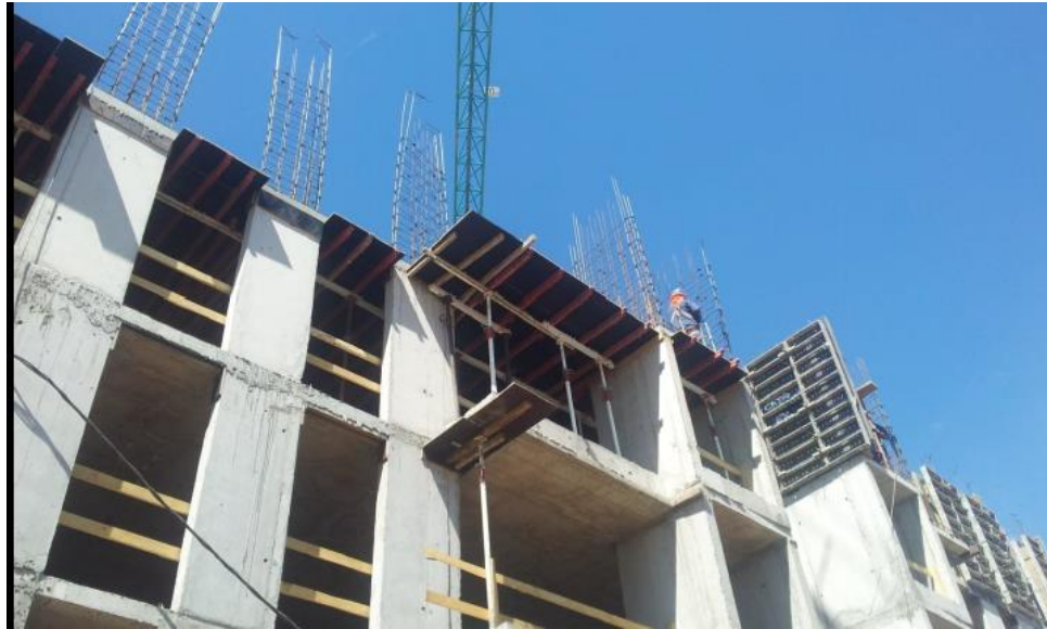
figura N°23: Registro fotográfico enfierradura y encofrado de muros villa futuro
