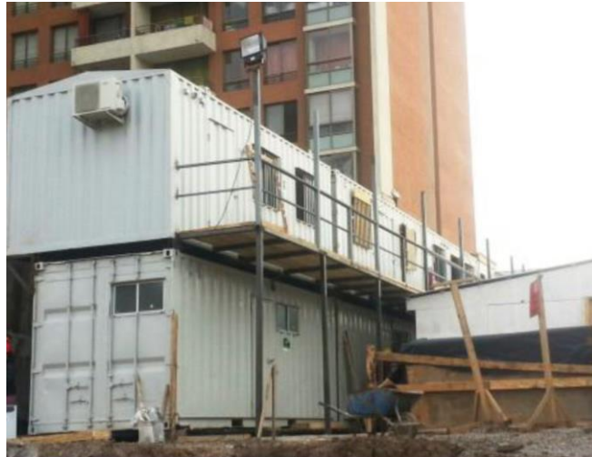
Figura N°28: Instalación de faenas dos niveles
