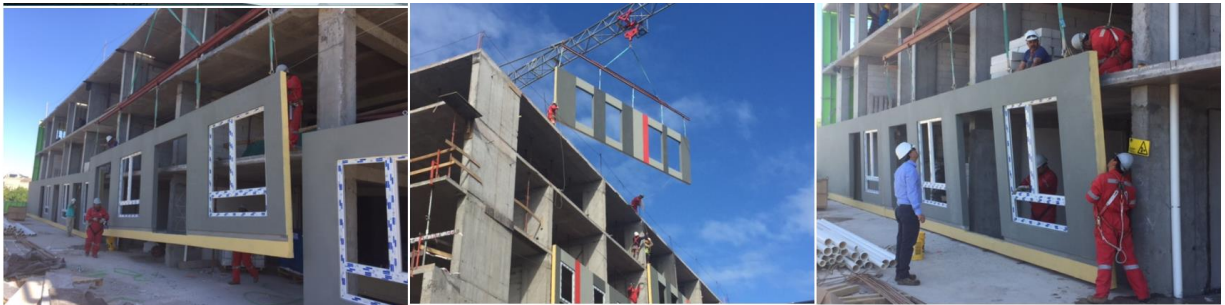
figura N°37: Industrialización fachadas empresa surpol
