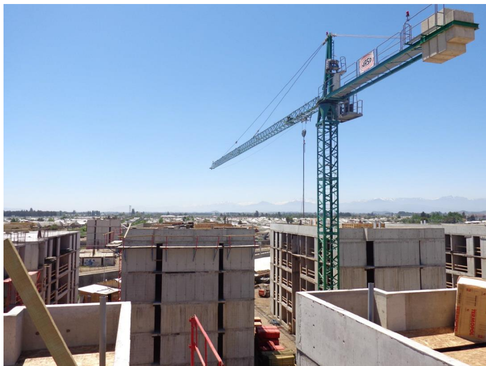
figura N°24: Registro fotográfico ubicación grúa torre villa futuro desarrollo edificios
