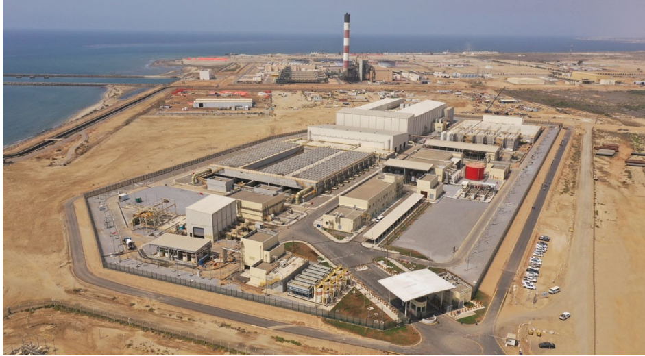
Figura 12: Planta Desaladora Shuaqaiq3, Arabia Saudita.
