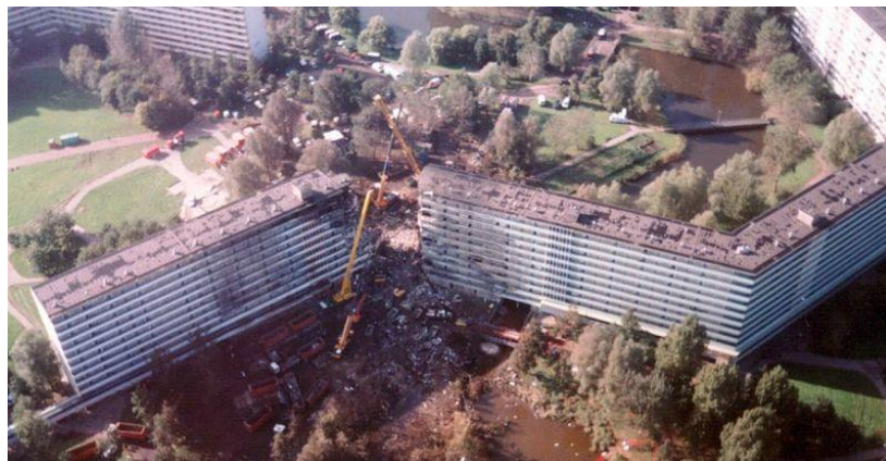
Ilustración 14: Estado del edificio tras el accidente del Boeing 747
