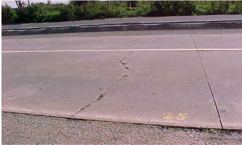
Ilustración 16: Pavimento de hormigón afectado por agrietamiento transversal.
