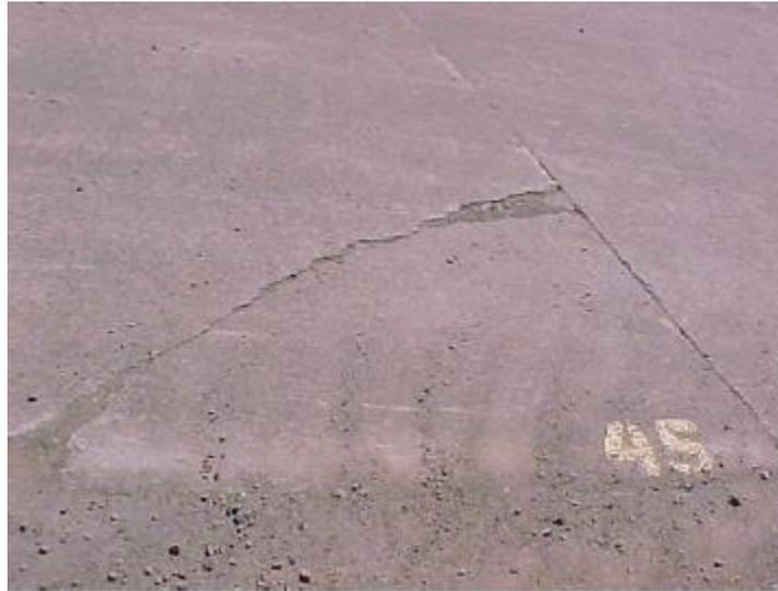
Ilustración 17: Pavimento de hormigón afectado por grieta tipo esquina.
