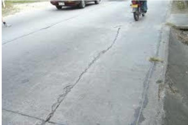
Ilustración 15: Pavimento de hormigón afectado por agrietamiento longitudinal.
