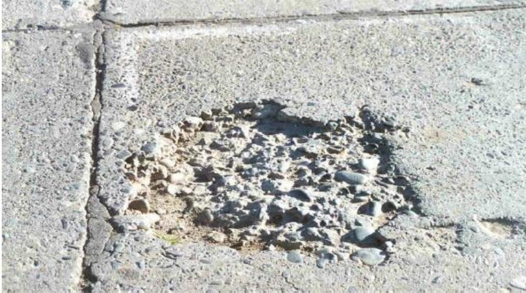
Ilustración 20: Pavimento de hormigón afectado por un bache.
