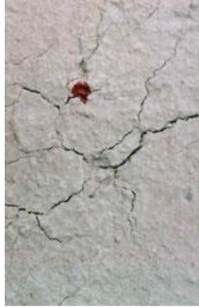
Ilustración 14: Pavimento de hormigón afectado por fisuras.
