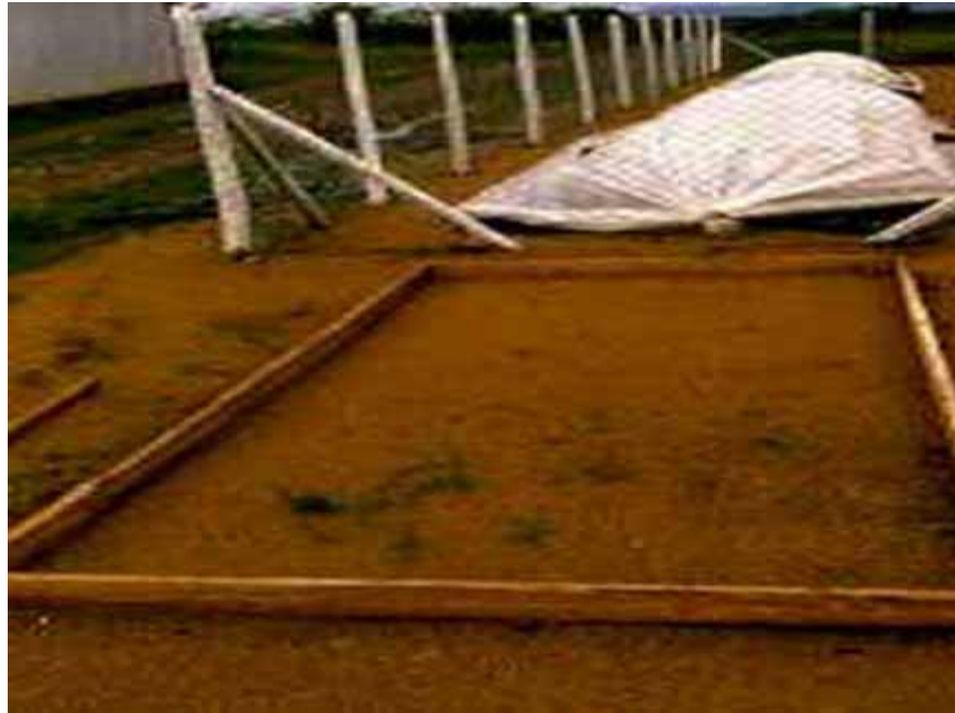
Fotografía 6: Marco de piscina construido con tablas de madera.
