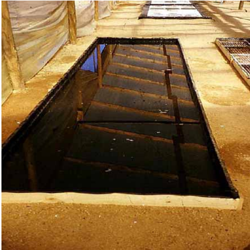
Fotografía 8: Piscina rellena con agua una vez que ha sido construida.
