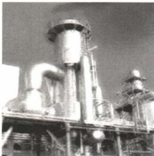
Imagen 2: Digestor de Biomasa, aprovecha Residuos Sólidos Urbanos (RSU), cuyo producto es Biogas o gas Metano, que se utiliza para generación de energía eléctrica, en Europa, región de Gran Bretaña.
