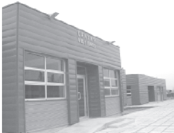
El Centro Tecnológico de la Vid y el Vino dispone ya de sus nuevas dependencias, aunque aun resta la habilitación del edificio para su traslado.
